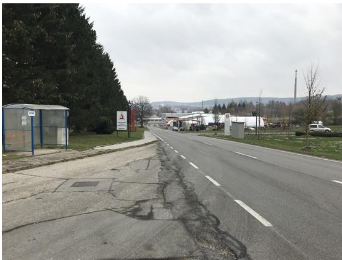
Obr. 39 - Humpolec zastávka Strojírny
