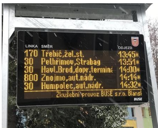
Obr. 34 - Informační systém pro cestující na zastávce Poliklinika
