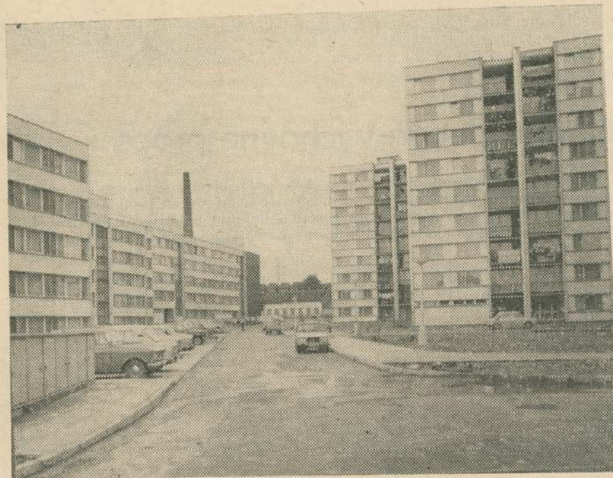
Sidliště Stromovka je dosud největším humpoleckým sídlištěm.
