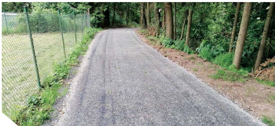
oprava lesní cesty v Petrovicích
