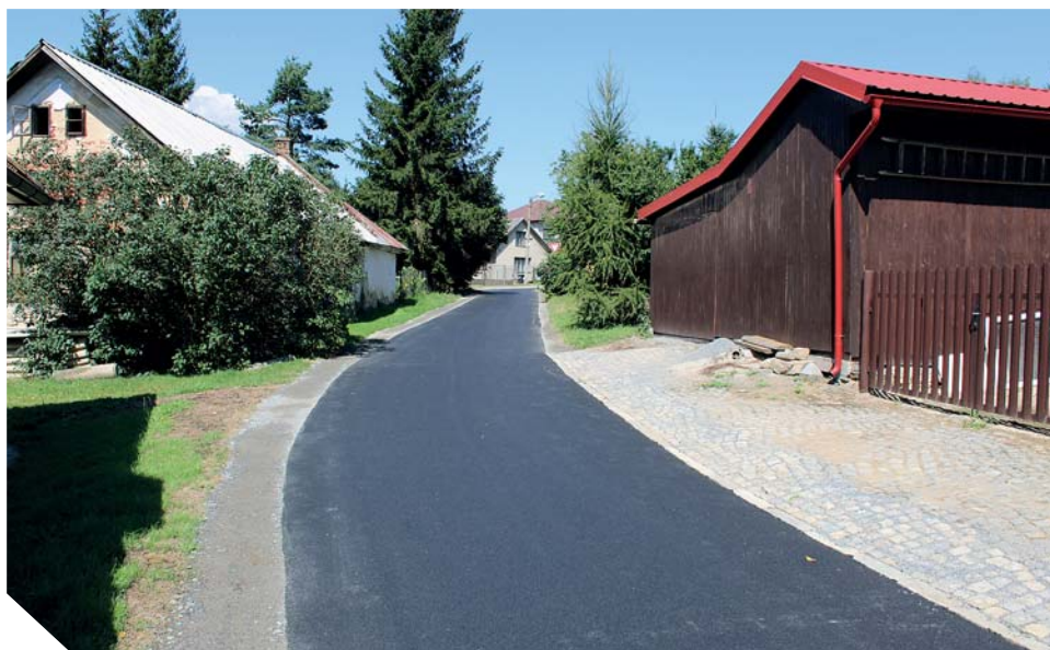
oprava místní komunikace v Krasoňově
